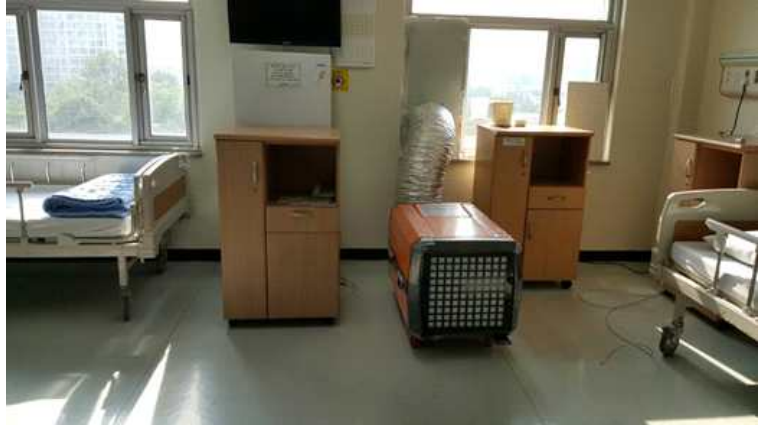
이동형 음압장비 설치
