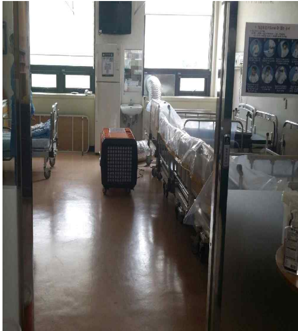
전실 및 음압기 설치
