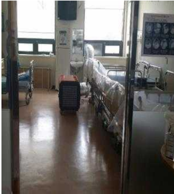
전실 및 음압기 설치
