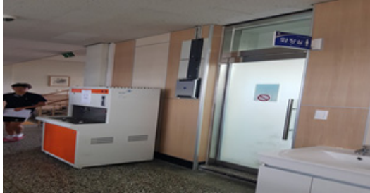
본관 음수제조기 및 세면대(화장실 앞 위치)
